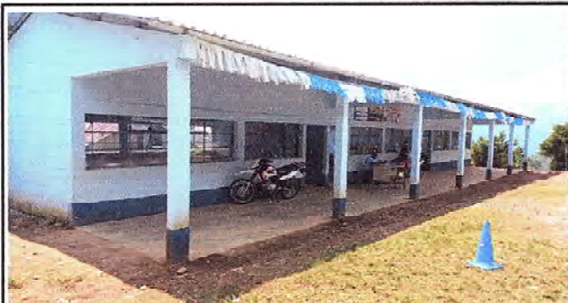
Foto1: Entechado ejecutado satisfactoriamente.
