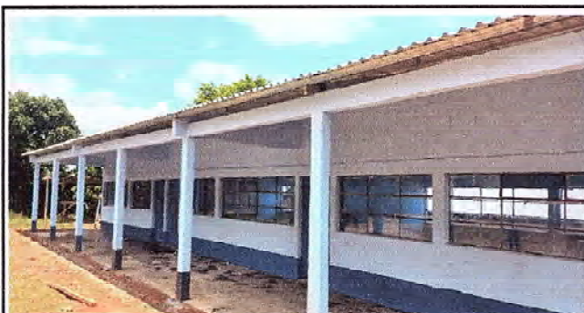
Foto 3: Ejecución de columnas.
