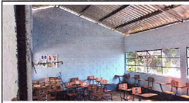
Foto 2: Colocación e instalación de costaneras metálicas.
