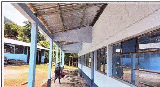
Foto 4: Levantamiento del techo ya ejecutado y culminado.
